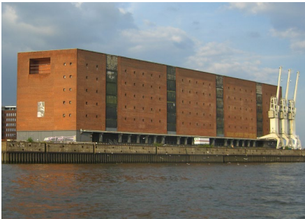
Bild 2. Der Kaispeicher A nach dem Wiederaufbau
